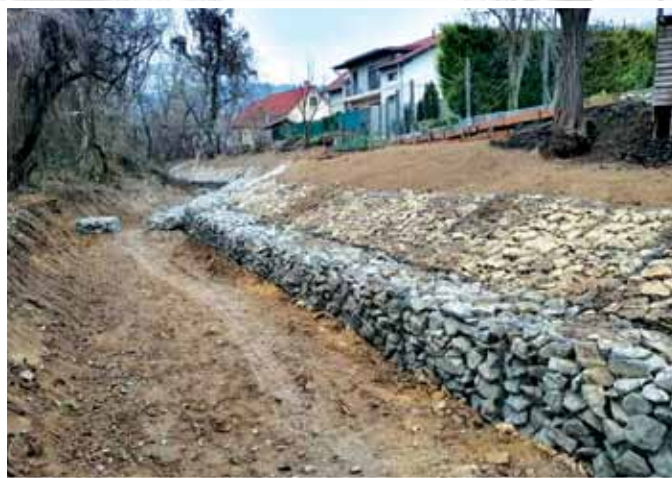
Pilisborosjenői patak Doktor utcai szakaszának helyreállítása
